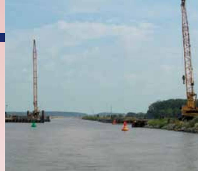
Werkzaamheden in het Wesel-Dattelnkanaal
